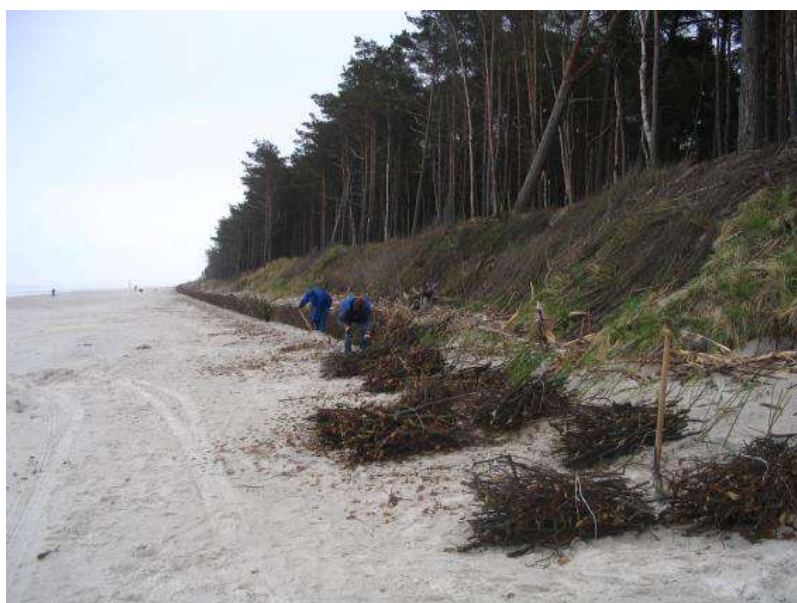
Fot. 4 Zakładanie płotków (fot. G. Różyński)
