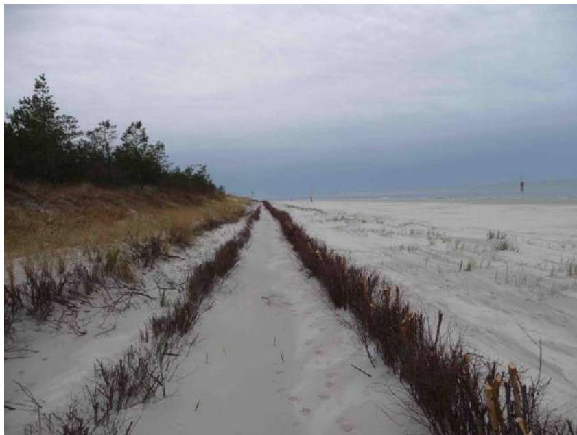
Fot. 1 Trzy rzędy płotków faszynowych; najbardziej odmorski rząd zbudowany jako ostatni – rzędy „wewnętrzne” częściowo pokryte zakumulowanym piaskiem, Lubiatowo ok. 2015 (fot. G. Różyński)
