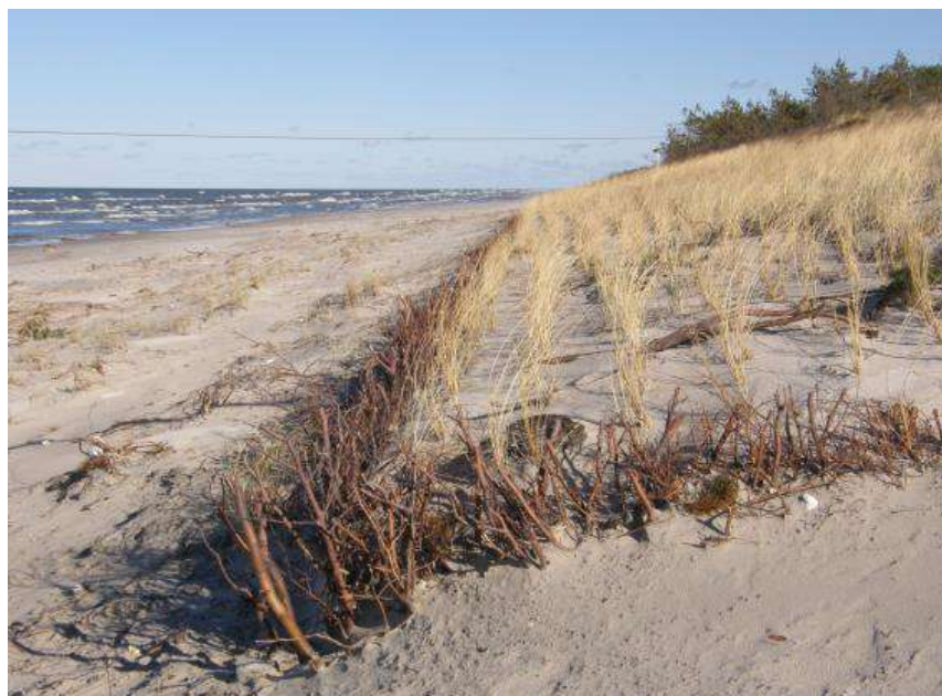
Fot. 2 Sztuczna wegetacja na odbudowanej wydmie, Lubiatowo ok. 2015 (fot. G. Różyński)
