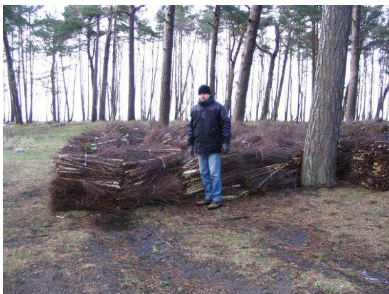
Fot. 3 Wiązki faszyny przygotowane do instalacji (fot. G. Różyński)
