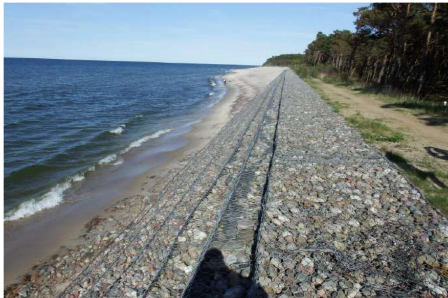
Fot. 3 Szkielet wydmy bez pokrycia piaskiem, Jastrzębia Góra – Ostrowo, 2015 (fot. G. Różyński)
