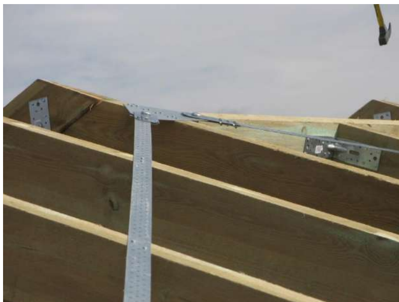
Zastosowanie systemu stężenia dachowego
