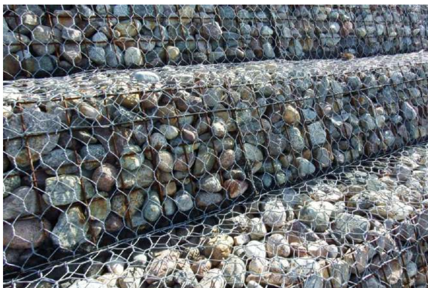
Fot. 2 Szczegóły konstrukcji gabionów, Jastrzębia Góra – Ostrowo, 2015 (fot. G. Różyński)
