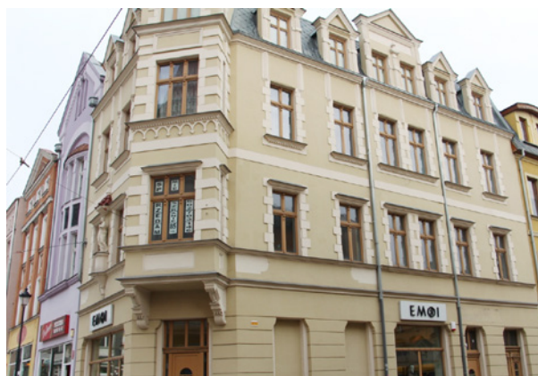
Zdjęcie nr 4 Budynek przy ul. Mickiewicza 1/Rynek 12 w Grudziądzu
